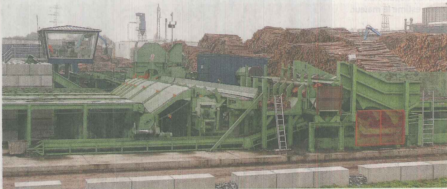
La nouvelle chaîne de triage du bois pour la paletterie a été aménagée au cœur de l'entreprise, et pas en périphérie comme espéré. © J.-L. B.
