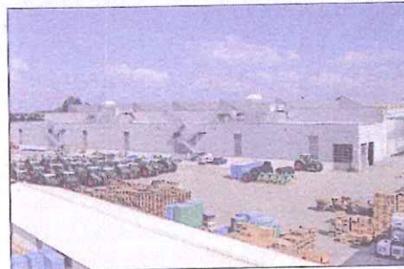
La nouvelle aile de l'usine de Marktobendorf qui accueillera en 2012 la nouvelle chaîne d'assemblage des tracteurs Fendt.
